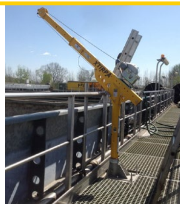
Braccio gru con base a terra
